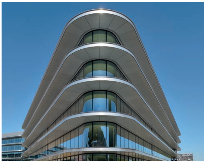
ING Hoofdkantoor, Ámsterdam, Países Bajos SunGuard® SN 70/35 | Acristalamiento triple curvado templado Arquitecto: Benthem + Crouwel architects | Foto: © Georges De Kinder
