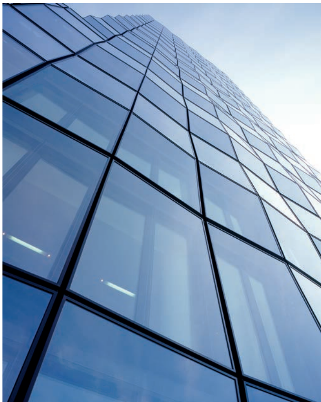
Süddeutscher Verlag, Múnich, Alemania SunGuard® HD Neutral 67 | Fachada de doble piel, capa dentro del laminado Arquitecto: GKK | Foto: © GKK+Architekten, Oliver Kuhn; Foto: Claus Graubner
