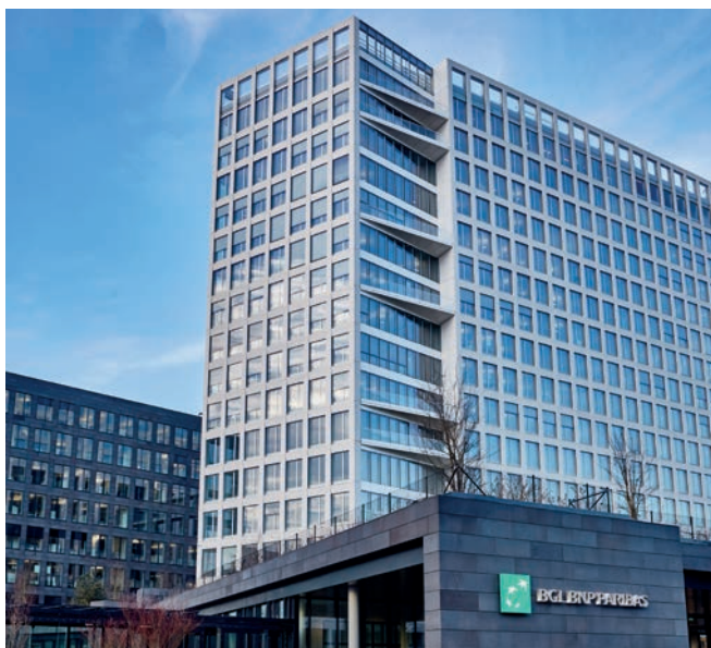
BGL BNP Paribas, Luxemburgo, Luxemburgo ClimaGuard® Dry | Fachada de doble piel, capa anticondensación en la superficie exterior Arquitecto: M3 Architectes | Foto: © Frank Weber
