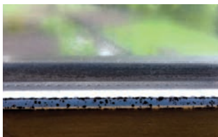
Abb. 4: Längerfristig droht dadurch Schimmelbildung, was nicht nur aus hygienischen Gründen inakzeptable ist
