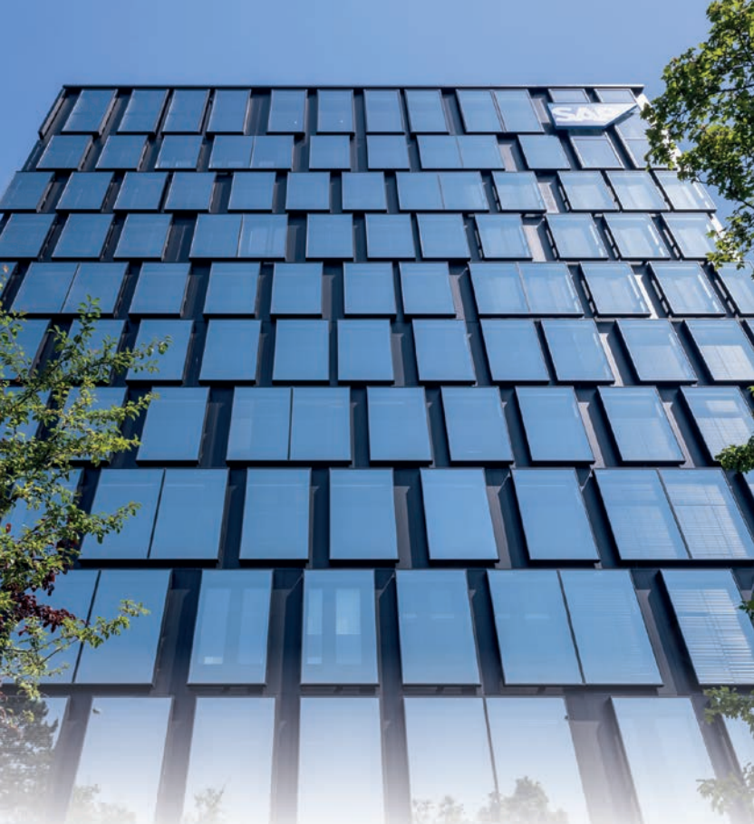
SAP Frankfurt, Frankfurt, Deutschland | SunGuard® HD Diamond 66 | Doppelhaut-Fassade Architekt: KSP/Frankfurt | Foto: © pierer.net
