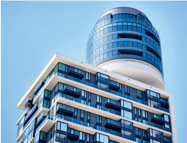
Henninger Turm, Frankfurt/M, Deutschland SunGuard® RD 60 | Radarreflexionsdämpfende Verglasung und Sonnenschutzglas Architekt: Meixner Schlüter Wendt (Frankfurt/M.) | Foto: © Frank Weber
