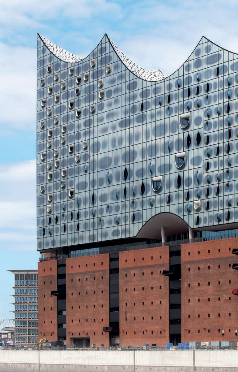
Elbphilharmonie Hamburg, Hamburg, Deutschland SunGuard® HD Light Blue 52 | 3-dimensional schwerkraftgebogenes, laminiertes und keramisch bedrucktes Isolierglas und Einfachglas Architekt: Herzog & De Meuron, Basel | Foto: © Cordelia Ewerth
