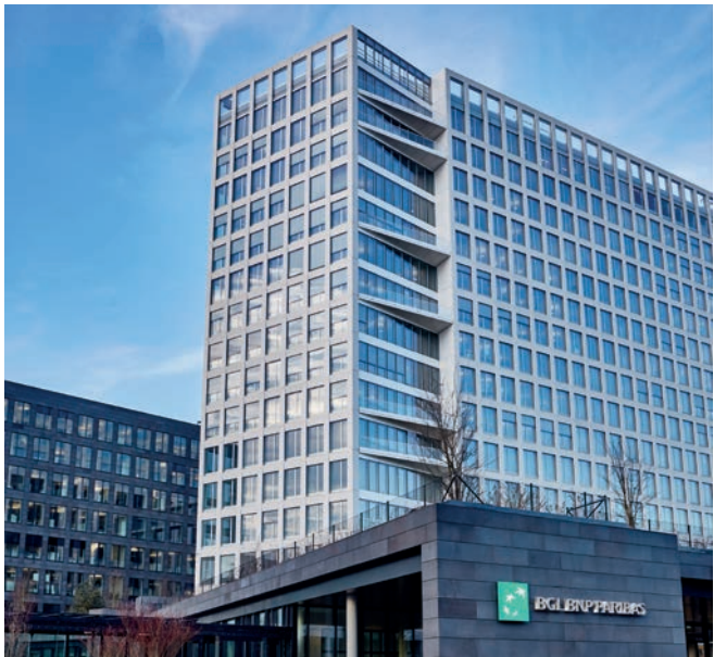
BGL BNP Paribas, Luxemburg, Luxemburg ClimaGuard® Dry | Doppelhaut-Fassade, Anti-Kondensat-Beschichtung an Außenseite der Prallscheibe
