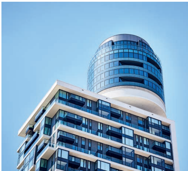
Henninger Turm, Frankfurt, Niemcy SunGuard® RD 60 | Szkło tłumiące promieniowanie radaru posiadające własności przeciwsłoneczne Architekt: Meixner Schlüter Wendt (Frankfurt/M.) | Zdjęcie: © Frank Weber
