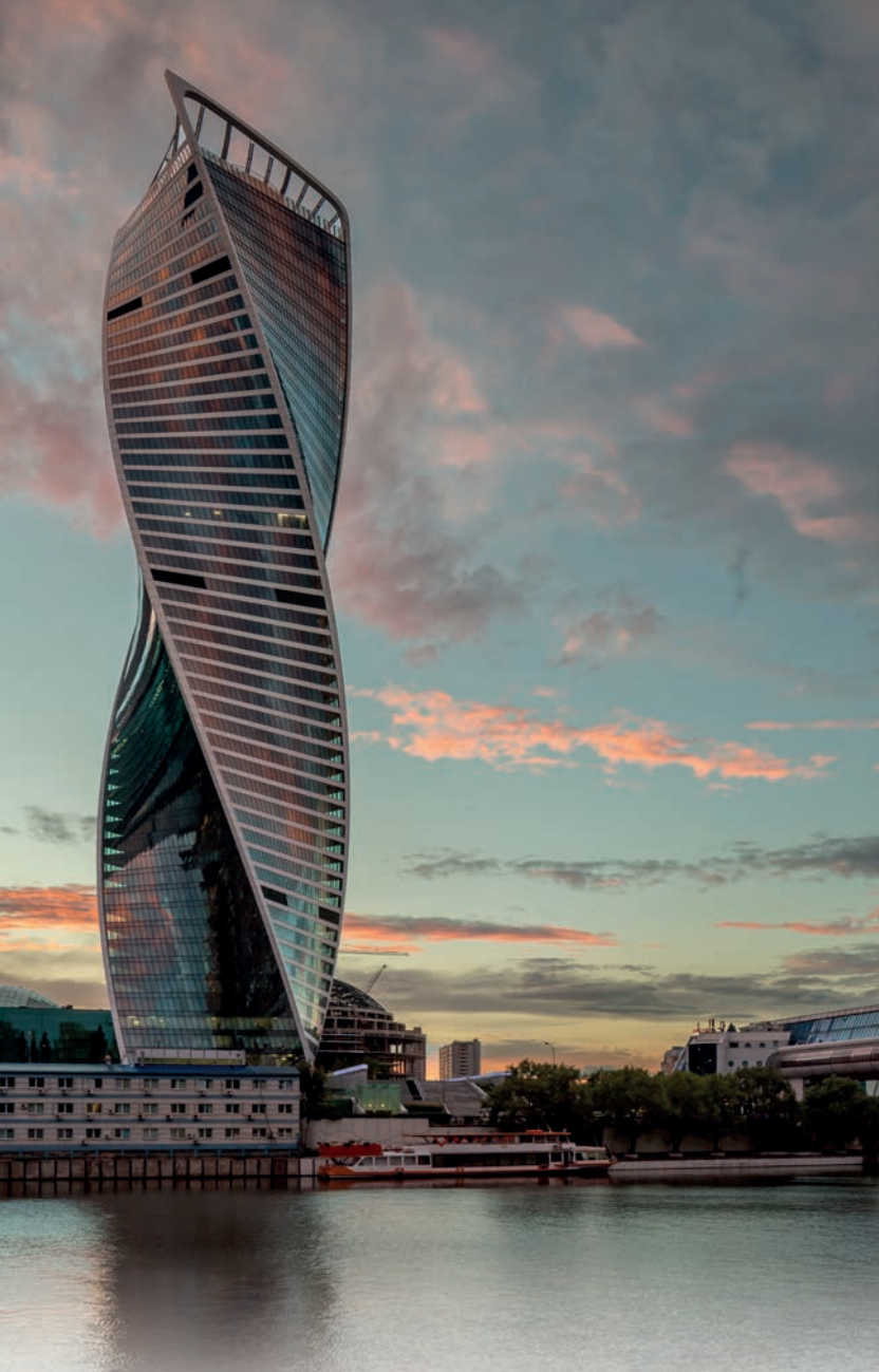
Evolution Tower, Moskwa, Federacja Rosyjska SunGuard® HP Neutral 60/40 | „Skręcona” fasada zbudowana z szyb zespolonych wygiętych na zimno Architekt: Tony Kettle | Zdjęcie: © Olga Alexeyenko
