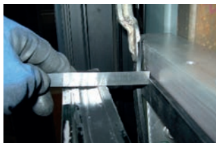
Przemieszczenie dZ, szyba zespolona przed umieszczeniem w giętej podkonstrukcji
