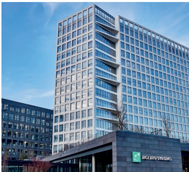
BGL BNP Paribas, Luksemburg, Luksemburg ClimaGuard® Dry | Fasada typu podwójna skóra, powłoka antykondensacyjna na stronie zewnętrznej Architekt: M3 Architectes | Zdjęcie: © Frank Weber
